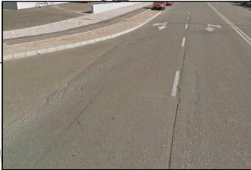
Firme deteriorado y señalización horizontal borrosa en algunos tramos.
