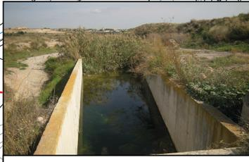
Salida colector de pluviales con falta de limpieza.
